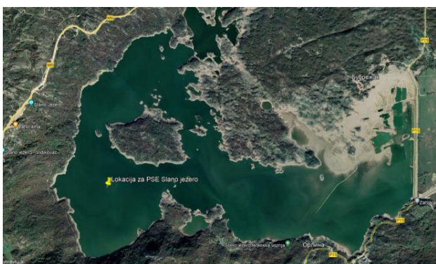
Slika 1. FN elektrana na Slanom jezeru
